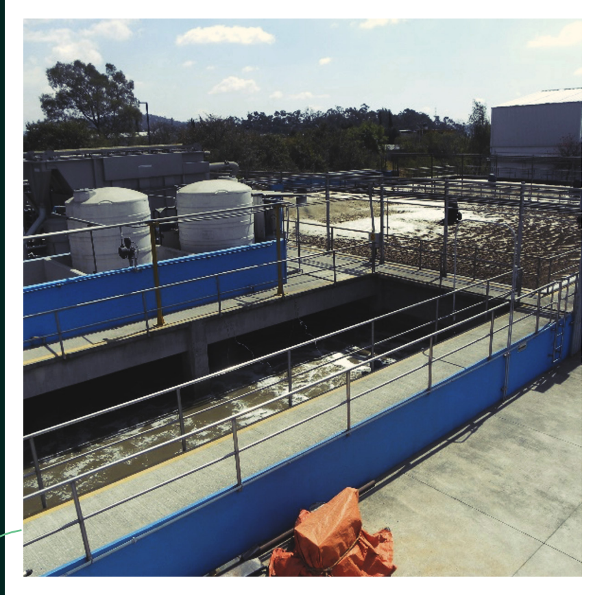
FIGURA 5.8 SISTEMA DE LODOS ACTIVADOS (FUENTE: II-UNAM)
