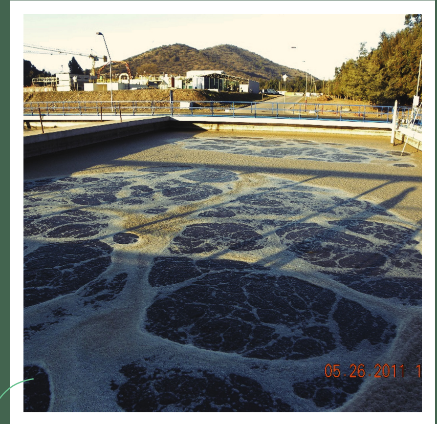
FIGURA 3.2 SISTEMA DE LODOS ACTIVADOS (FUENTE: IBTECH)
