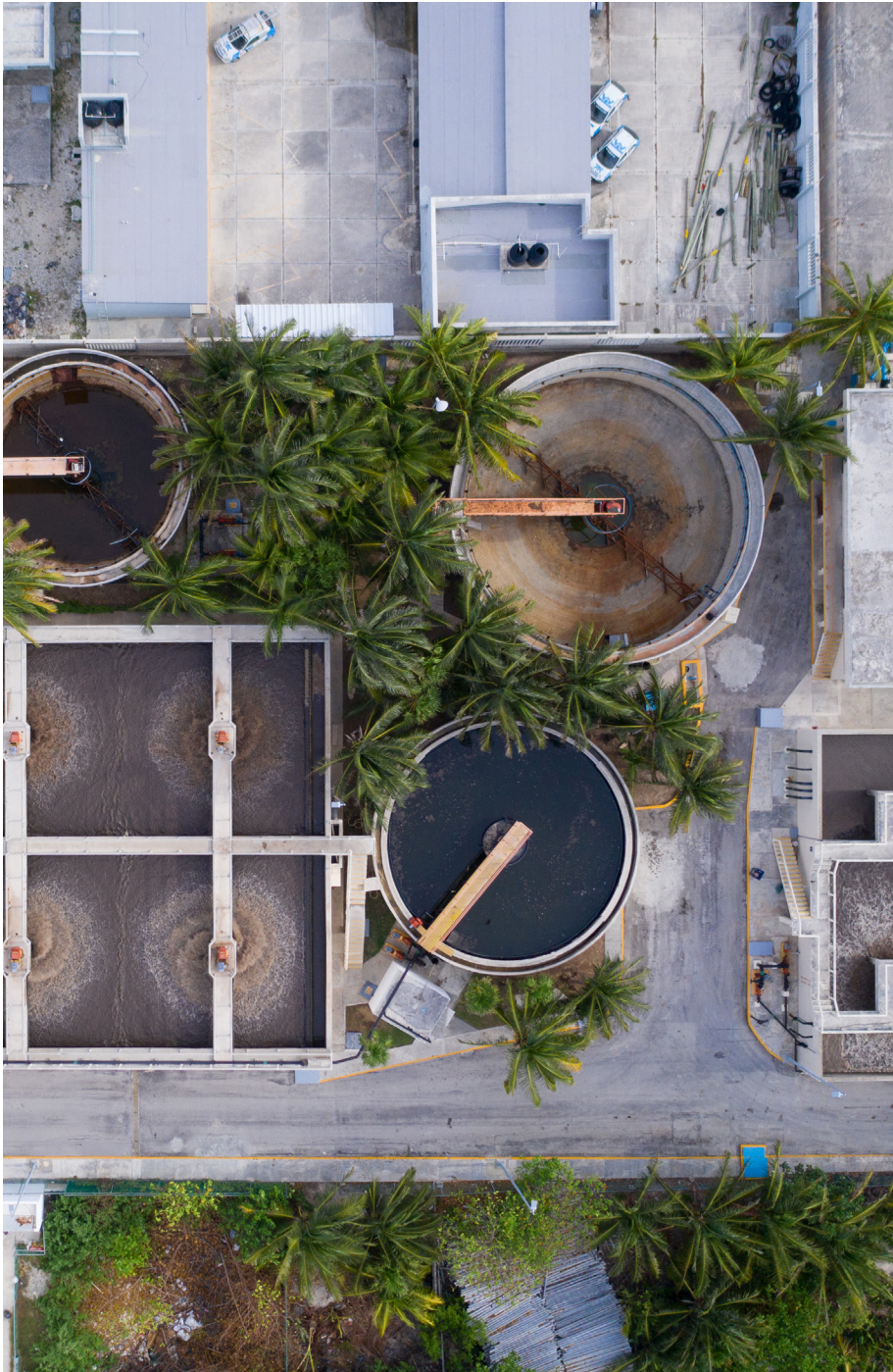
Planta de Tratamiento de Aguas Residuales por lodos activados en Quintana Roo, México (foto: Archivo ASK).
