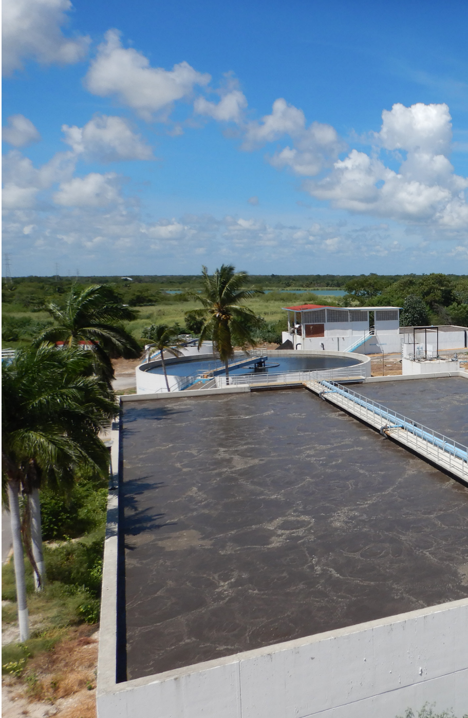
Planta de Tratamiento de Aguas Residuales por Lodos Activados y Cuerpo Receptor (foto: Rosa María Loreto).
