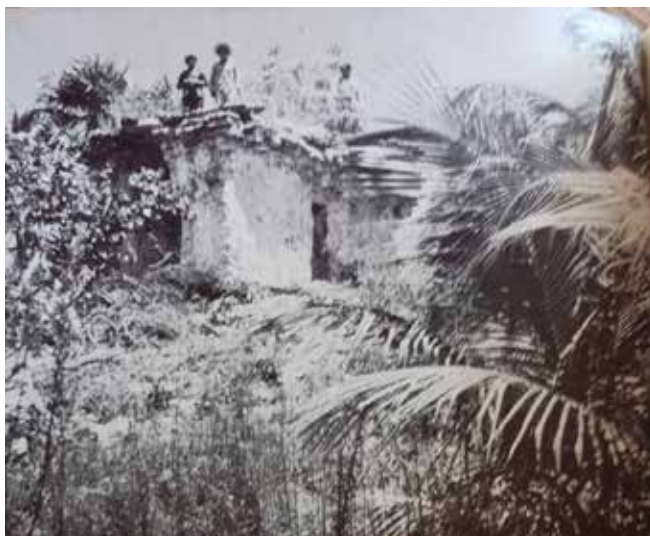
Estructura principal de San Miguel de Ruz
