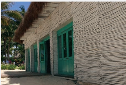
Cortina de varas de madera que protegen del sol la pared exterior del edificio. Hotel Mayan Palace, Riviera Maya
