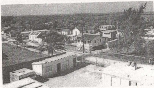
Xcalak cuenta con la infraestructura y los servicios básicos para la población
