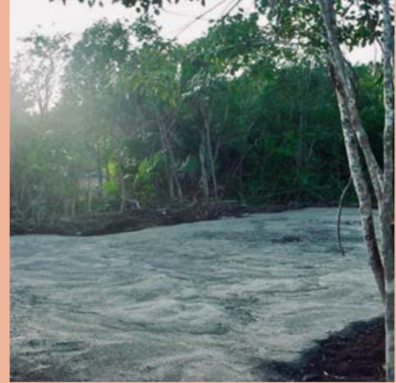
Figura 14: Remate de losa de concreto ciclópeo para desplante de cimentación. Por: LAAC.
