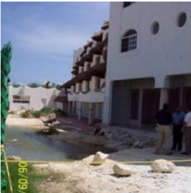
Figura 26: Hundimiento repentino de techo de caverna no detectada por falta de estudio exploratorio. Por: A&D asociados.
