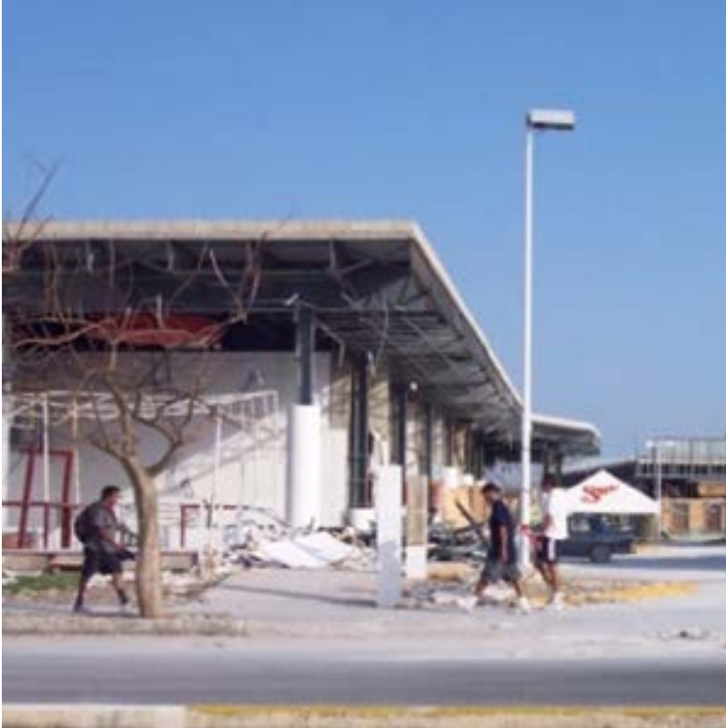
Figura 42: Locales comerciales en Plaza las Avenidas habiendo utilizado plafón en su exterior. Después del paso del huracán Wilma. Por: A&D asociados.
