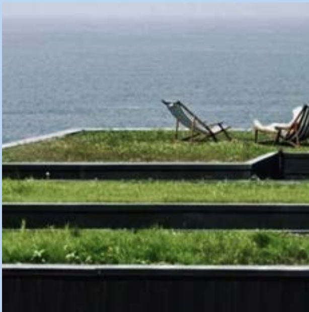
Figura. 11. Techos verdes Fuente: Dominio Web
