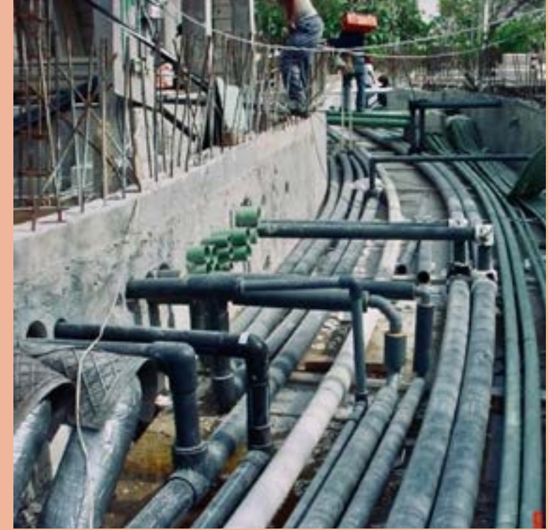
Figura 18: Instalaciones de trinchera. Por: LAAG.
