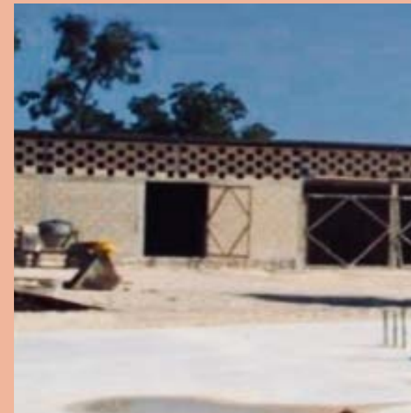
Figura 04: Bodega de obra. Por: JMMM.
