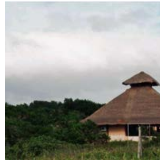
Figura 19: Cubierta autoventilada tipo palapa. Por: MMD.
