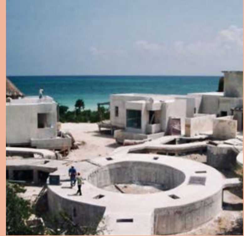
Figura 20: Trinchera terminada que servirá como rodamiento. Por: LAAG.
