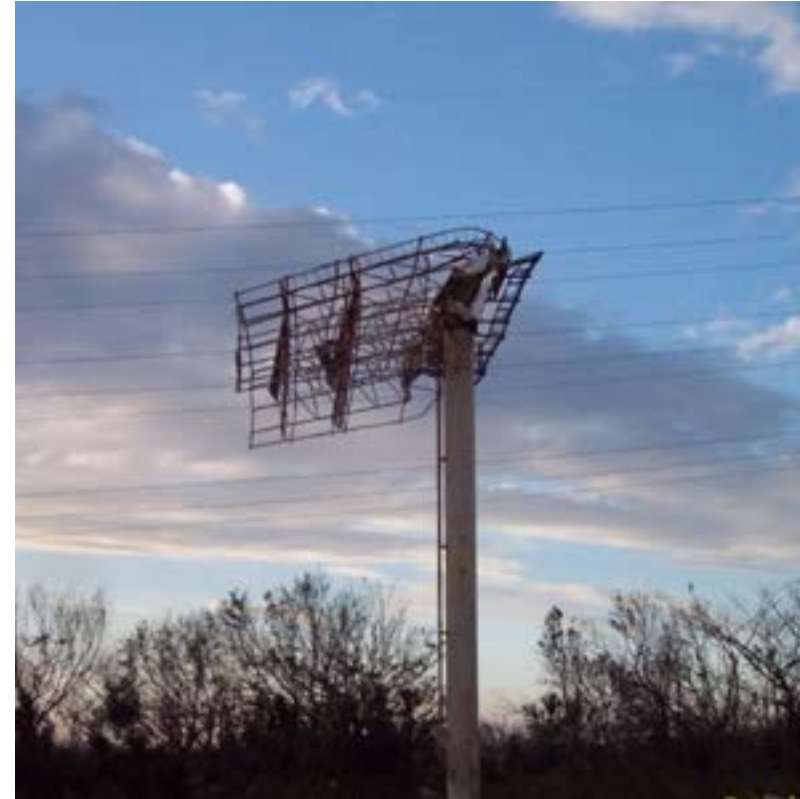
Figura 04: Estado límite de servicio. Falla por acción de empuje del viento Por: A&D Asociados.
