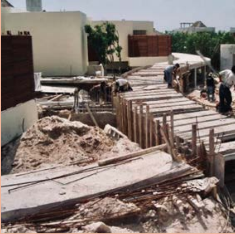
Figura 19: Colocación de tapas de trinchera. Por: LAAG.
