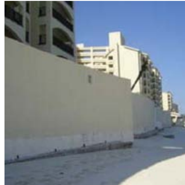
Figura 39: Muros de contención que resistieron las cargas por empuje de olas. Después del paso de Huracán Wilma, Cancún 2005. Fuente: SMIE
