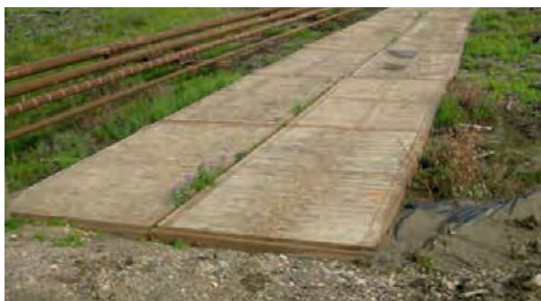
Imagen: Plataforma de acceso temporal de metal y madera. Fuente: FPInnovations and Ducks Unlimited Canada. (2016). Resource Roads and Wetlands: A Guide for Planning, Construction, and Maintenance.
