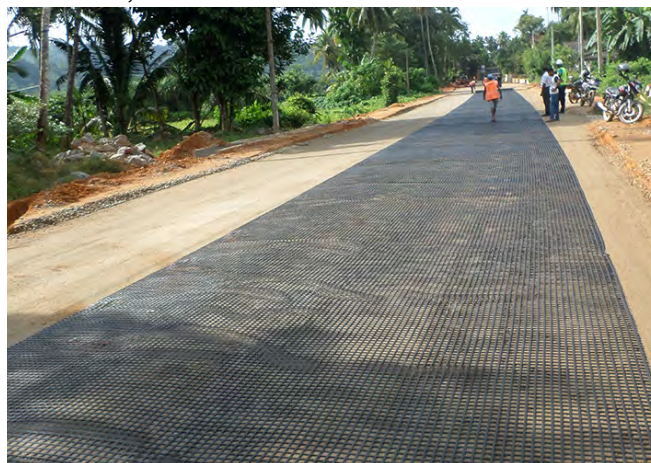
Imagen: Uso de geotextil en construcción de vialidad Fuente: www.skytech.lk
