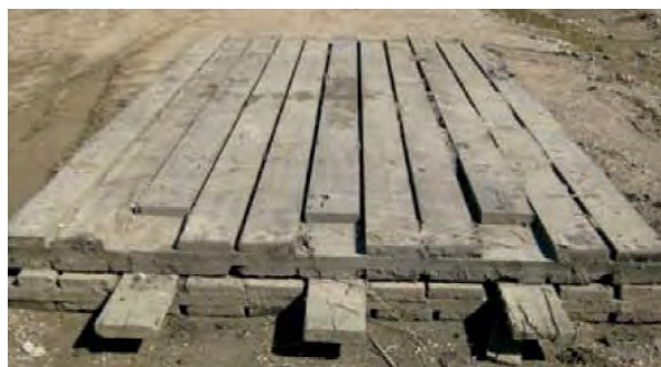
Imagen: Plataforma de acceso temporal de madera. Fuente: FPInnovations and Ducks Unlimited Canada. (2016). Resource Roads and Wetlands: A Guide for Planning, Construction, and Maintenance.
