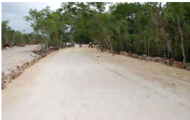
Imagen: Ejemplo de camino con material sascab, Quintana Roo Fuente: Sascab, 2015. https://vdocuments.mx/sas-cab.html
