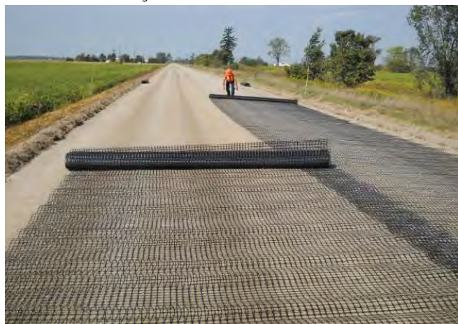
Imagen: Uso de geotextil en construcción de vialidad Fuente: theconstructor.org
