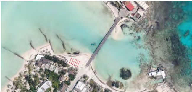
Imagen : Vista aérea puente vehicular. Fuente: googlemaps
